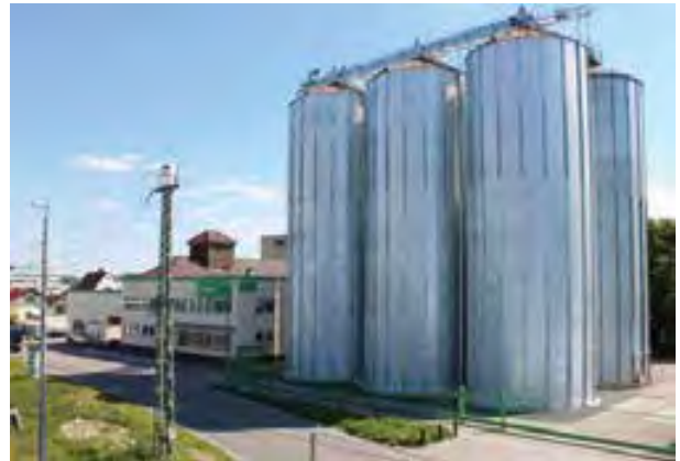
Anlagen in Bau, Erweiterung der Siloanlage in Sinsheim, Fertigstellung 2013
