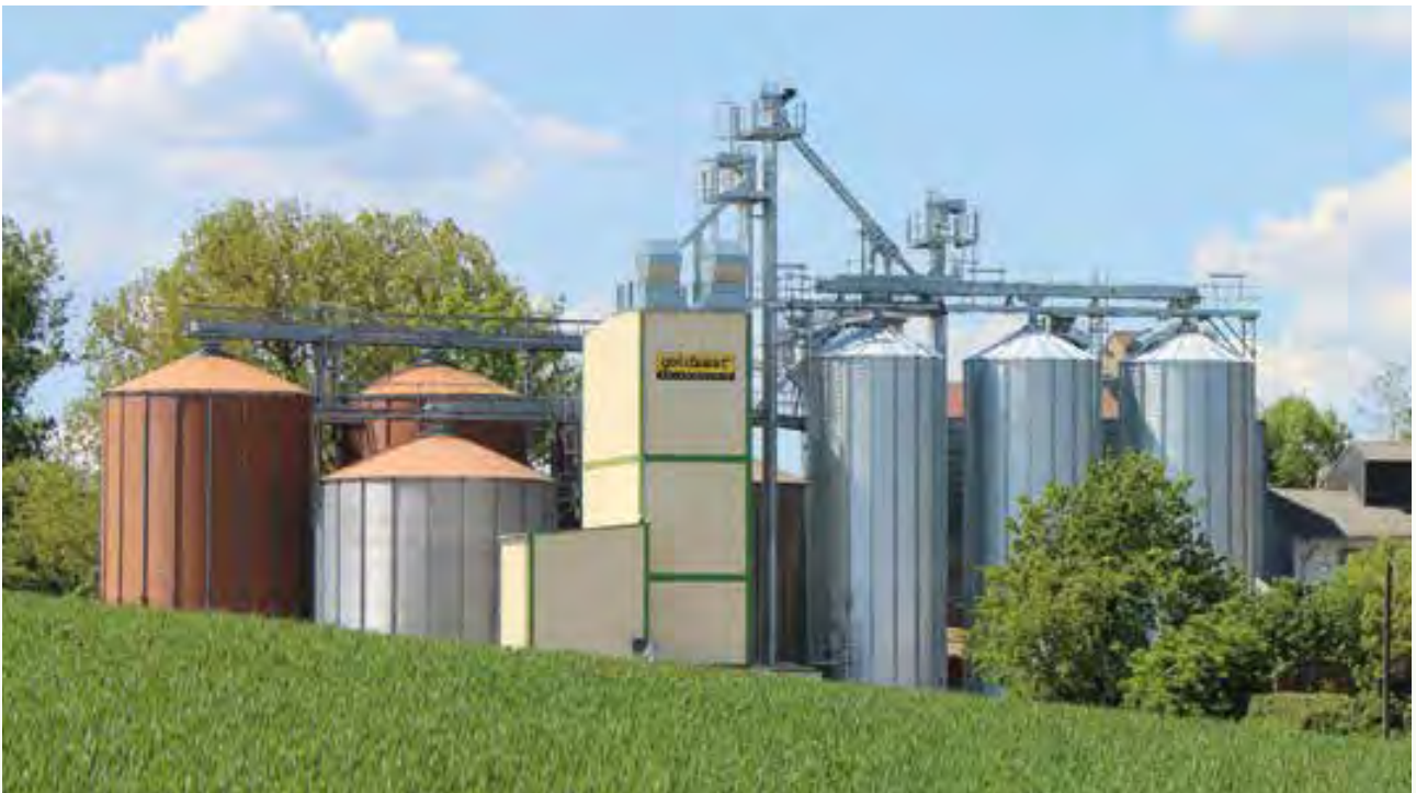
Neubau einer Trockner- und Siloanlage in Flinsbach
