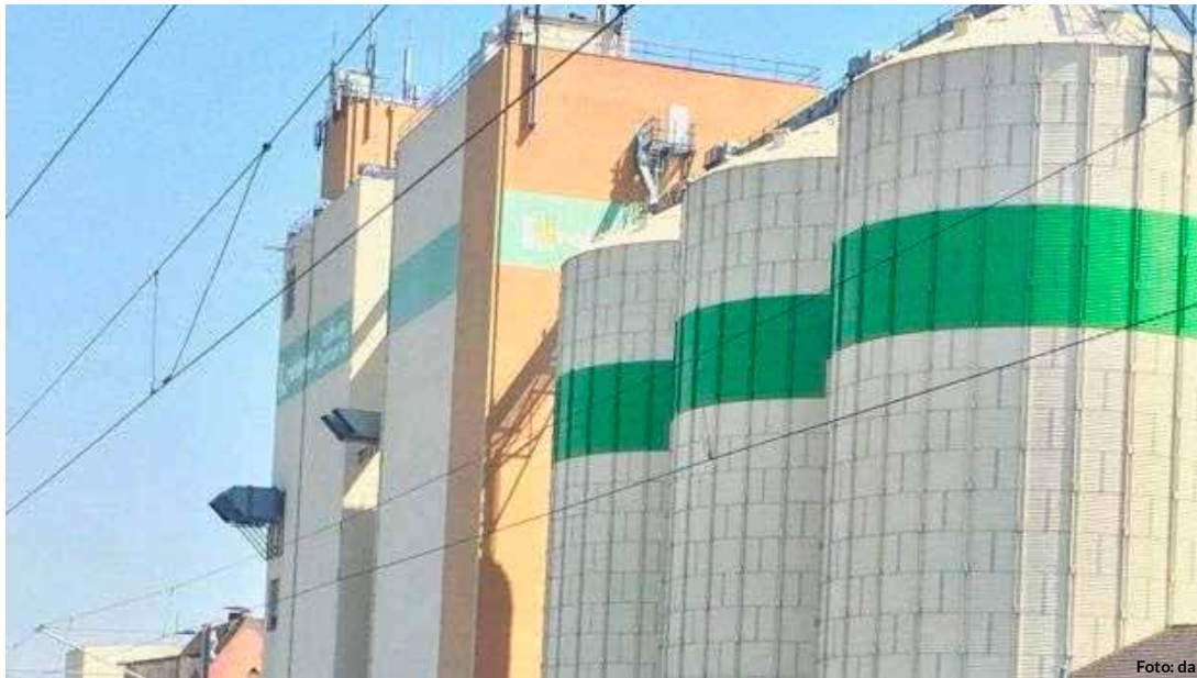
Die Kraichgau Raiffeisen Zentrum (KRZ) in Eppingen/Baden-Württemberg.
