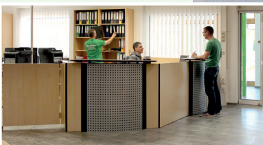
Sanierungsarbeiten im Verwaltungsgebäude
