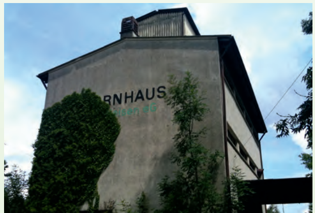
Abbruch Kornhaus in Grombach
