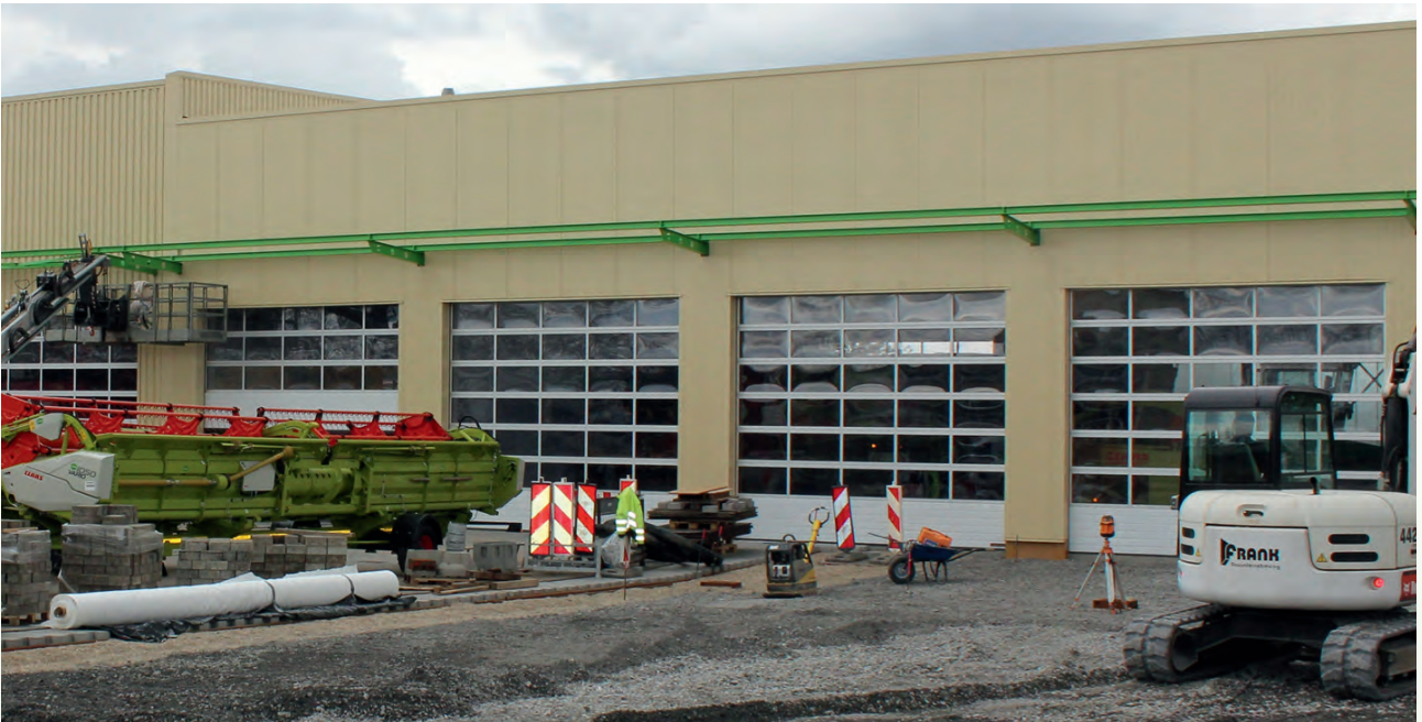
Anlagen im Bau, Erweiterung der Landmaschinenwerkstatt in Eppingen, Fertigstellung 2012
